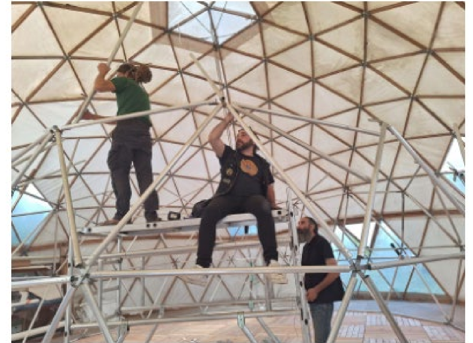
Montage du dôme géodésique – Compagnie Le TIR et la Lyre
